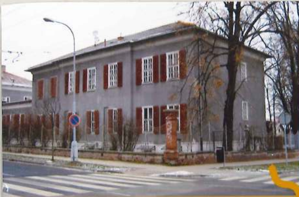
Kulturní zařízení Univerzity obrany, Šumavská ul. 20. 9. 1993 - 22. 12. 2010
